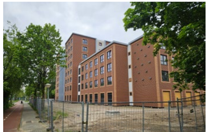
M20 in aanbouw. ♦ Foto Resource
